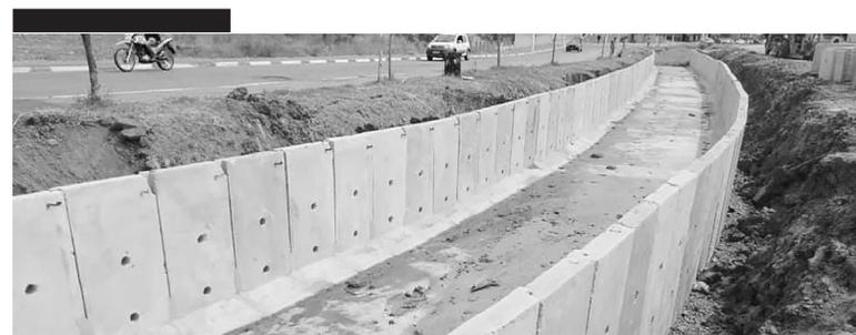
**Córrego Pinheirinho:** As obras da fase II de canalização do córrego Pinheirinho seguem em ritmo acelerado. Já estão sendo instaladas as aduelas em concreto, bem como a concretagem do canal. Posteriormente, segundo o Serviço Autônomo de Água e Esgoto (SAAE) o trecho receberá a instalação de guarda-corpo metálico, ampliação das calçadas com blocos intertravados e novo paisagismo.
