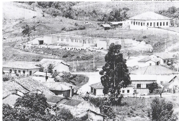
Na foto, a escola em construção
